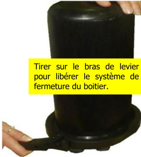
Tirer sur le bras de levier pour libérer le système de fermeture du boîtier.
