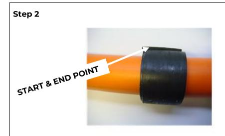
THE START & END POINT OF THE TAPE MUST BE AT THE SIDE OF THE CABLE AND ORIENTATED THE SAME BOTH ENDS OF THE CABLE. PRESS ALONG THE END POSITION FIRMLY TO ENSURE THE TAPE STICKS SECURELY TO ITSELF.
