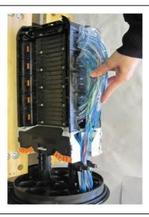
• Pousser soigneusement les boucles de tubes dans la partie ouverte de la zone de stockage.
