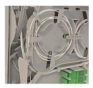
• **Dettaglio del passaggio laterale** dalla zona di gestione fibre alla rastrelliera Rete Orizzontale.
