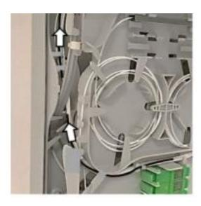
• Dettaglio del passaggio laterale (da Piastra 2 a Piastra 0).
