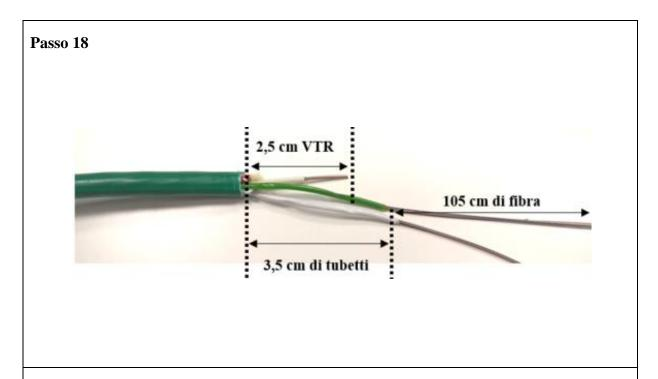
• Per installare il cavo di rete assicurarsi di aver preparato il cavo lasciando esposti 3,5 cm di tubetti, 105 cm di fibre nude, 2,5 cm di elemento di rinforzo.
